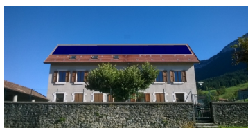
Toiture modifiée de l'Ecole Primaire de Rencurel
