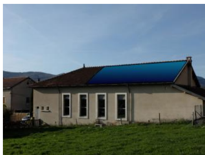
Toiture modifiée de la salle des fêtes de Saint Julien en Vercors
