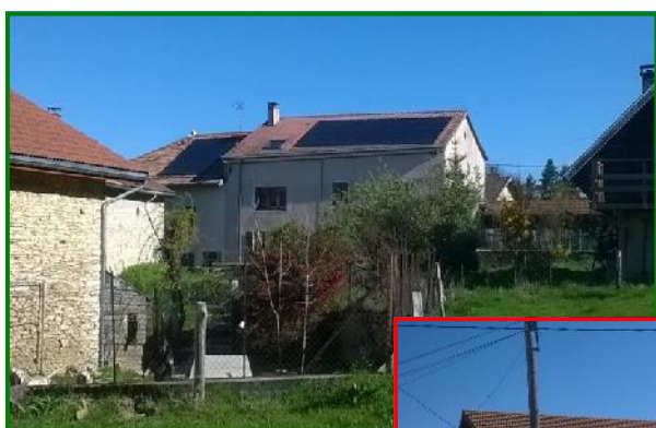
Toiture de la Maison Pecot à Saint Martin en Vercors
